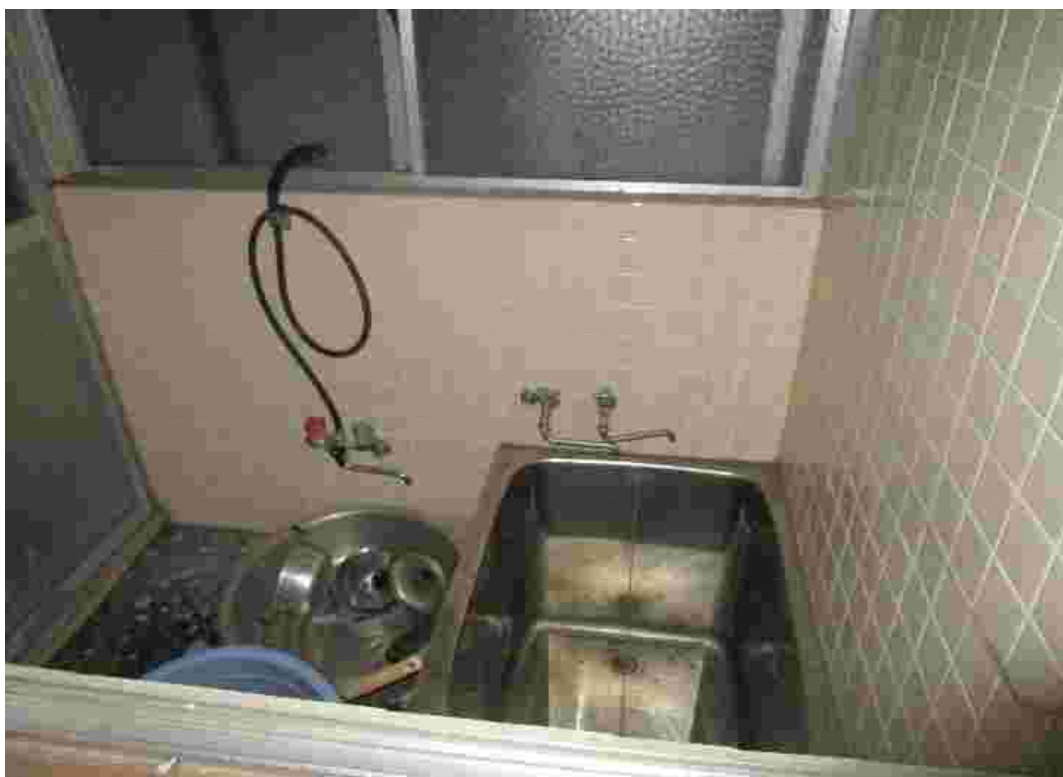
撮影方向⑦（浴室）
