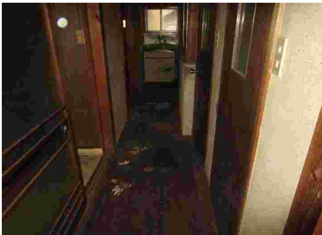
撮影方向⑨（廊下）
